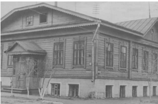
Старое здание Алтайского филиала ВНИИМС
